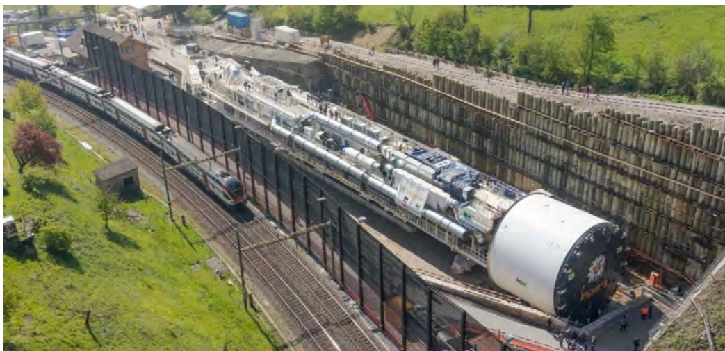
Figur 7. TBM-maskin vid Bözbergtunneln i Schweiz. (Amberg group, 2023).
